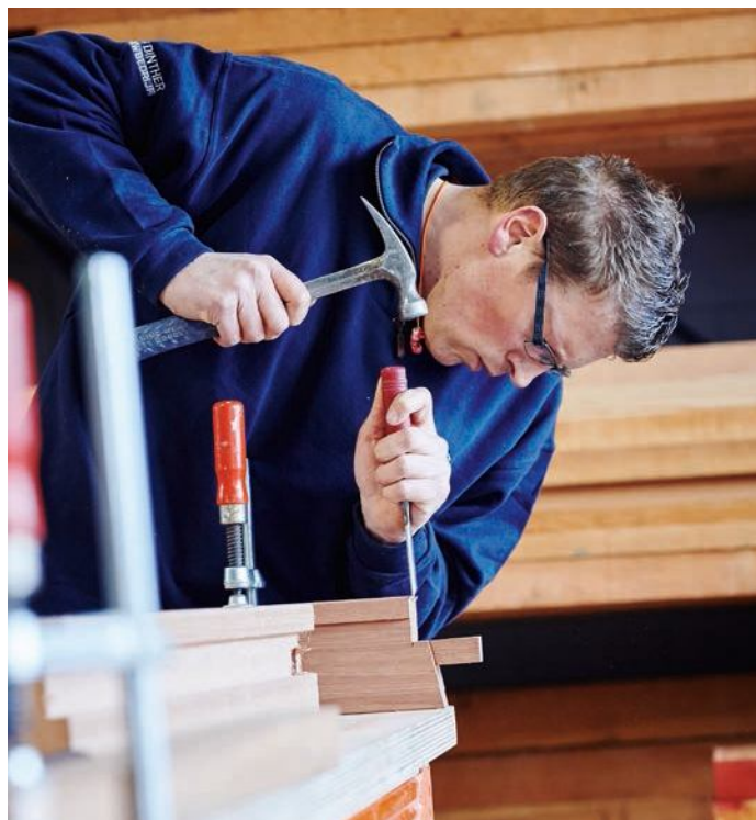
Restauratietimmerman Alex de Louw werkt aan een proefstuk voor het 'aanhelen' van een kozijn.
